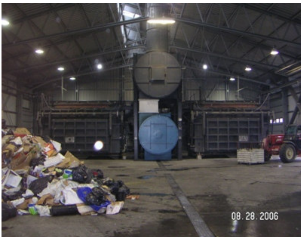
l'impianto di Husavik, dall'interno dello stabilimento
