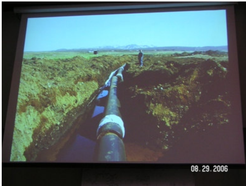
una fase dell'interramento dei tubi di trasporto del vapore alla centrale geotermoelettrica
